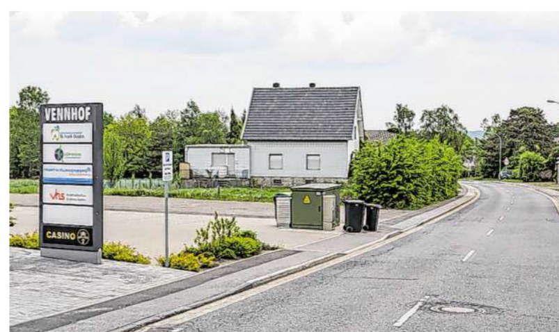
Das Haus unterhalb des Vennhofs an der Faulenbruchstraße in Roetgen soll abgerissen werden: Die Mitglieder des Bauausschusses der Gemeinde stimmten für einen entsprechend Antrag. Foto: A. Gabbert
